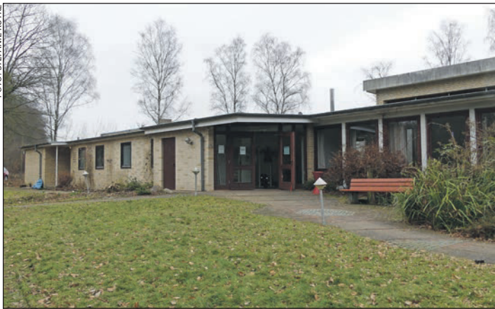
Der Kirchengemeindesaal und die Nebengebäude werden im Februar abgerissen, um Platz zu machen für den Neubau.
